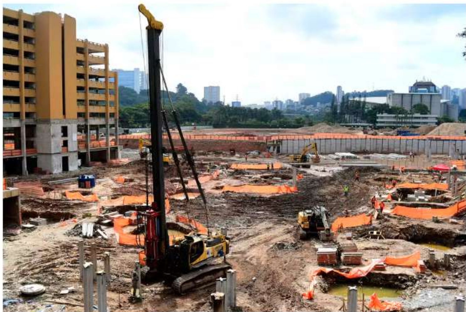
Obras de uma das futuras piscinas de ondas de São Paulo — Foto: Marcos Ribolli
