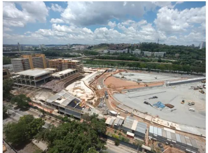
Obra em andamento do Beyond Club (2024) (Divulgação/Divulgação)
